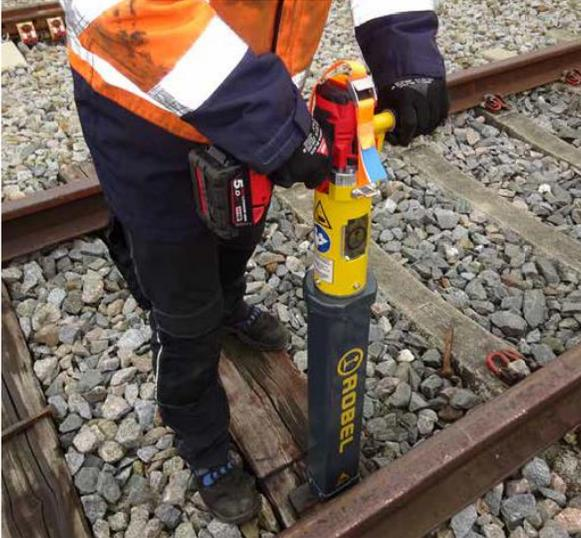
MÁQUINA PARA EXTRAER CLAVOS A BATERÍA
